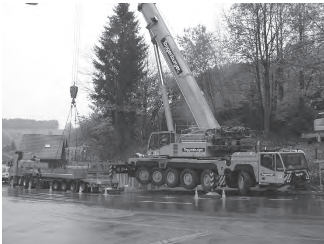
Montage der Betonelemente mit 300 to Kran
