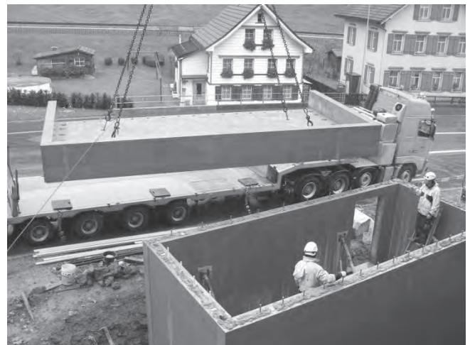
Aufsetzen des Daches....
