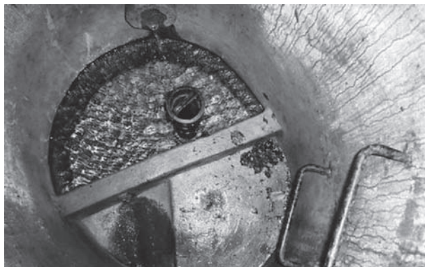
Innenansicht Brunnenstube bisher (Baujahr 1896)
